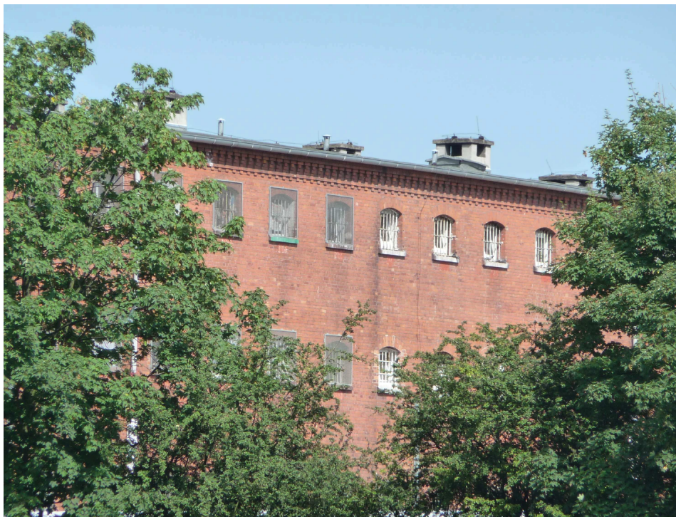
Zdj 13 Widok okien w zakładzie karnym w Rawiczu
