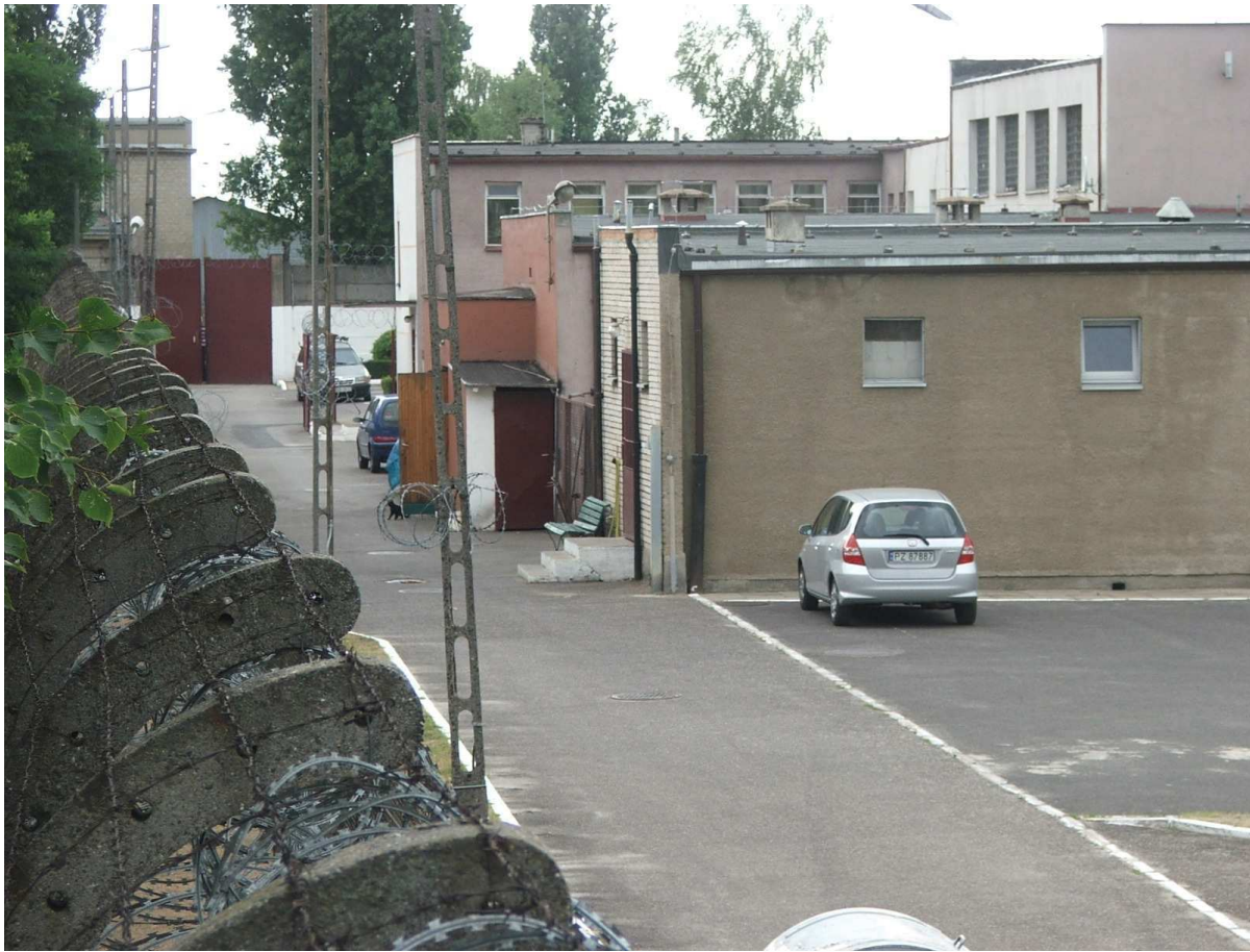
Zdj. 2 Na pierwszym planie - sala komputerowa, pomiędzy – wejście do kuchni, na końcu – pomieszczenia administracyjne widziane od tyłu.
