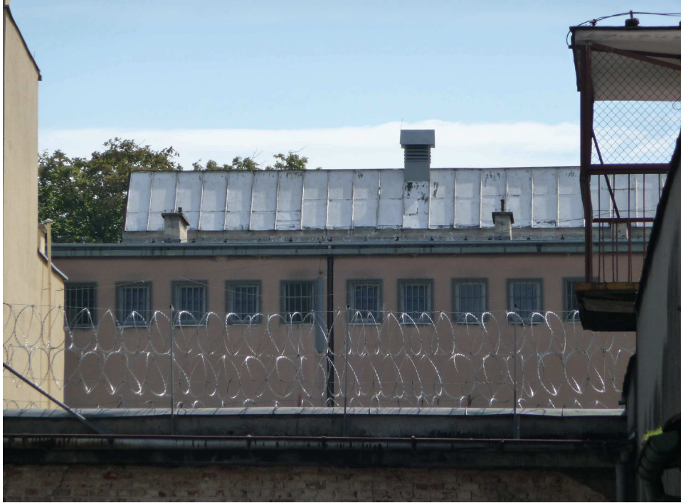
Zdj 14 Widok okien w zakładzie karnym w Rawiczu
