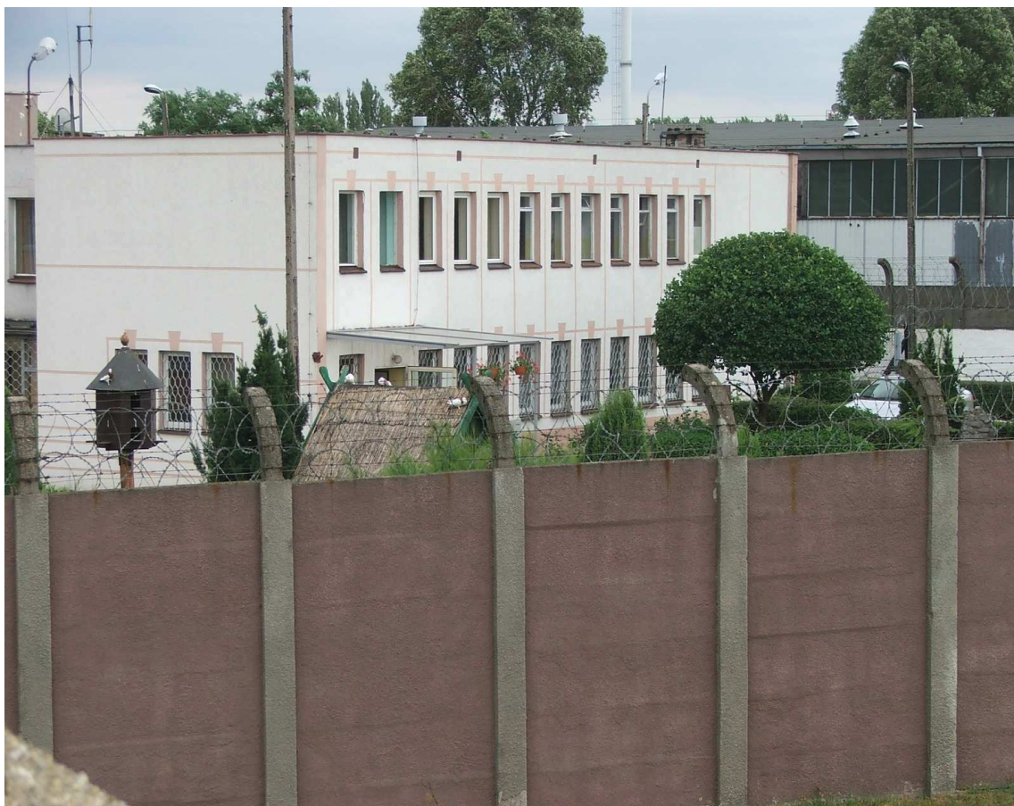
Zdj. 1 W oddali widzimy wejście na dyżurkę dowódcy, nieokratowane okna na piętrze to gabinet dyrektora i pomieszczenia administracyjne.
